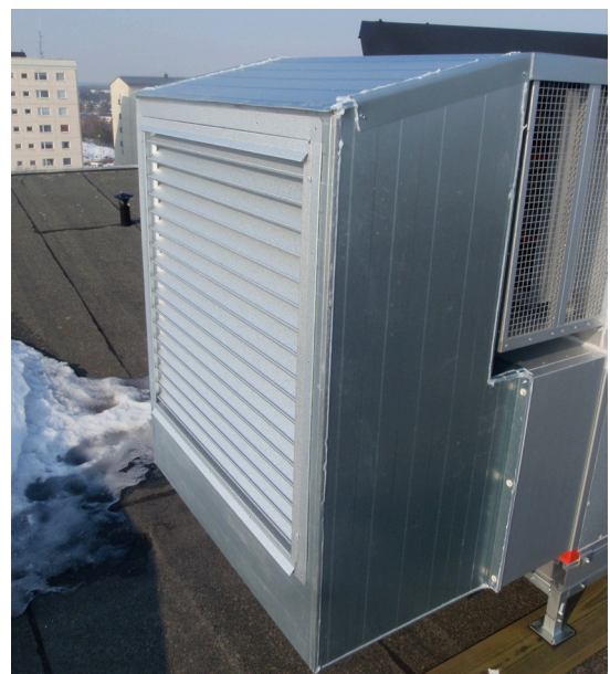
Luftintag med nytt "snöskydd"
